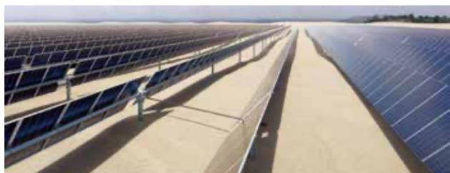
L'inseguitore Agile 1P a doppia fila è compatibile con tutti i moduli, comprese le celle da 210 mm. Il cuscinetto sferico, di proprietà di TrinaTracker, il cardano e la barra di trasmissione rendono questo inseguitore la soluzione più adatta per le installazioni in siti complessi con terreni difficili.
