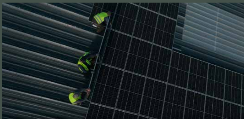
IL MONTAGGIO DEL SISTEMA È STATO COMPLETATO IL 30% PIÙ RAPIDAMENTE DEL PREVISTO.
