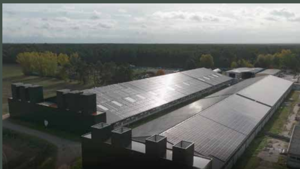
AEROCOMPACT HA FORNITO IL SUO SISTEMA A BINARI COMPACTMETAL PER L'INSTALLAZIONE DI UN IMPIANTO DA 1,8 MWp SULLE COPERTURE DI DUE CAPANNONI IN GERMANIA
