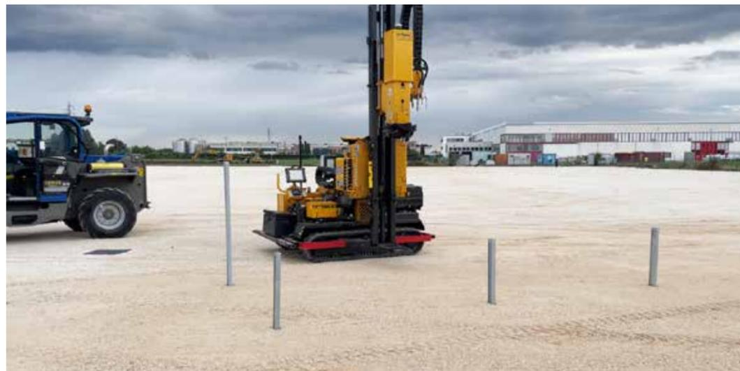
ALBASOLAR HA UTILIZZATO DIVERSE TECNOLOGIE ALL'AVANGUARDIA: DALLA MAPPATURA DEI TERRENI PER MEZZO DI UNO SPECIALE DRONE PROFESSIONALE, ALL'INSERIMENTO VIA WEB DELLE COORDINATE GPS NELLA MACCHINA PIANTAPALI CHE HA POTUTO PIANTARE NEL TERRENO AUTONOMAMENTE E IN MODO PRECISO I PALI DI SOSTEGNO IN ACCIAIO
