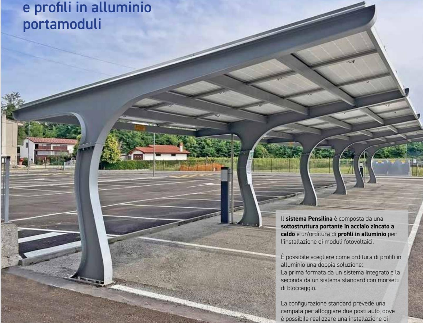
Il sistema Pensilina è composta da una **sottostruttura portante in acciaio zincato a caldo** e un'orditura di **profili in alluminio** per l'installazione di moduli fotovoltaici.
