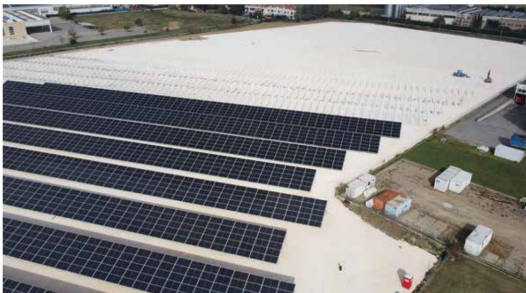
PER LA REALIZZAZIONE DELL'IMPIANTO A TERRA SI È SCELTO DI ADOTTARE UNA SOLUZIONE POCO INVASIVA E DI FACILE REVERSIBILITÀ. È STATO UTILIZZATO IL SISTEMA DI INFILAGGIO DIRETTO NEL TERRENO DEI PALI DI SOSTEGNO E NON È STATO IMPIEGATO CEMENTO
