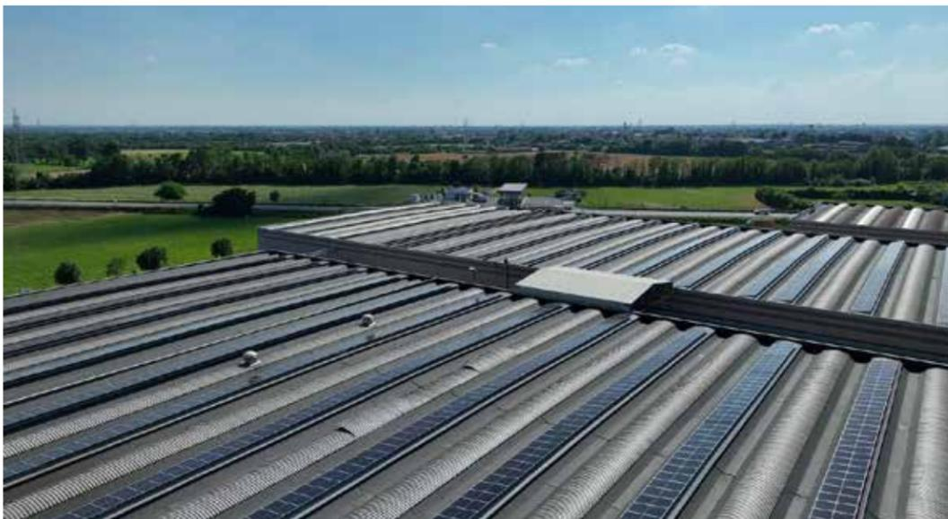
La società valtellinese Elvi S.p.A. ha completato un progetto di revamping e repowering per l'headquarter del Gruppo Tesmec ubicato a Grassobbio (BG), installando un impianto fotovoltaico da 1,55 MWp composto da 4.270 moduli fotovoltaici Seraphim da 450 Wp e 15 inverter Siel da 100 kW. Il montaggio dell'impianto è terminato a marzo 2023, ma l'allaccio Enel ha avuto luogo a maggio 2024. La durata dell'intervento è stata di cinque mesi, soprattutto durante quelli invernali.
