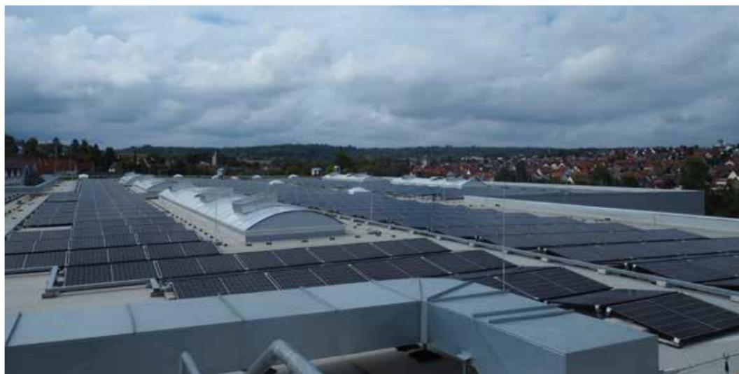
SULLA COPERTURA DELL'HEADQUARTERS È PRESENTE UN IMPIANTO FOTOVOLTAICO DA 663 KWP, A CUI SI AGGIUNGE UNA FACCIATA FOTOVOLTAICA DA 73 KWP, PER UN TOTALE DI 736 KWP. L'AZIENDA AUTOCONSUMA TUTTA L'ENERGIA PRODOTTA DALL'IMPIANTO
