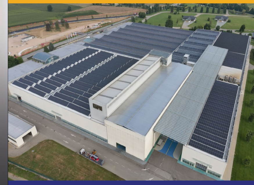
IMPIANTO A TETTO Piemonte
