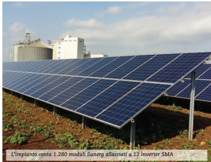
L'impianto conta 1.280 moduli Sunerg allacciati a 12 inverter SMA
